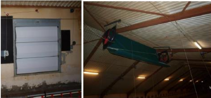
Voorbeeld van lamellen (Louvre-systeem) in zijgevel en luchtopvang in de nok.
